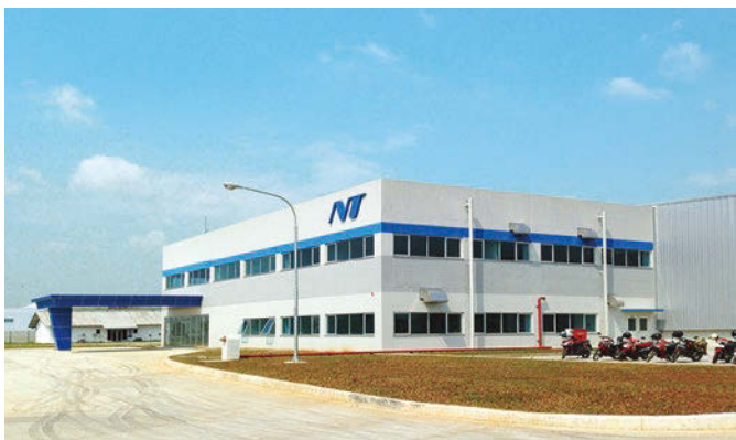
インドネシア / PT. NT INDONESIA (OFFICE/FACTORY)
